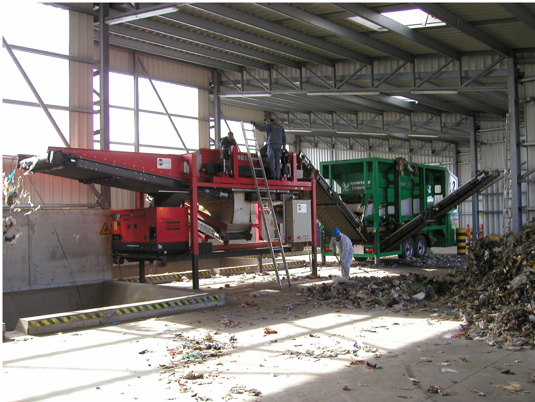
Abbildung 2.6: Aufbau und Betrieb der mobilen Siebanlage (Abwurf der Grobfraktion > 80 mm im Bild vorne links)
